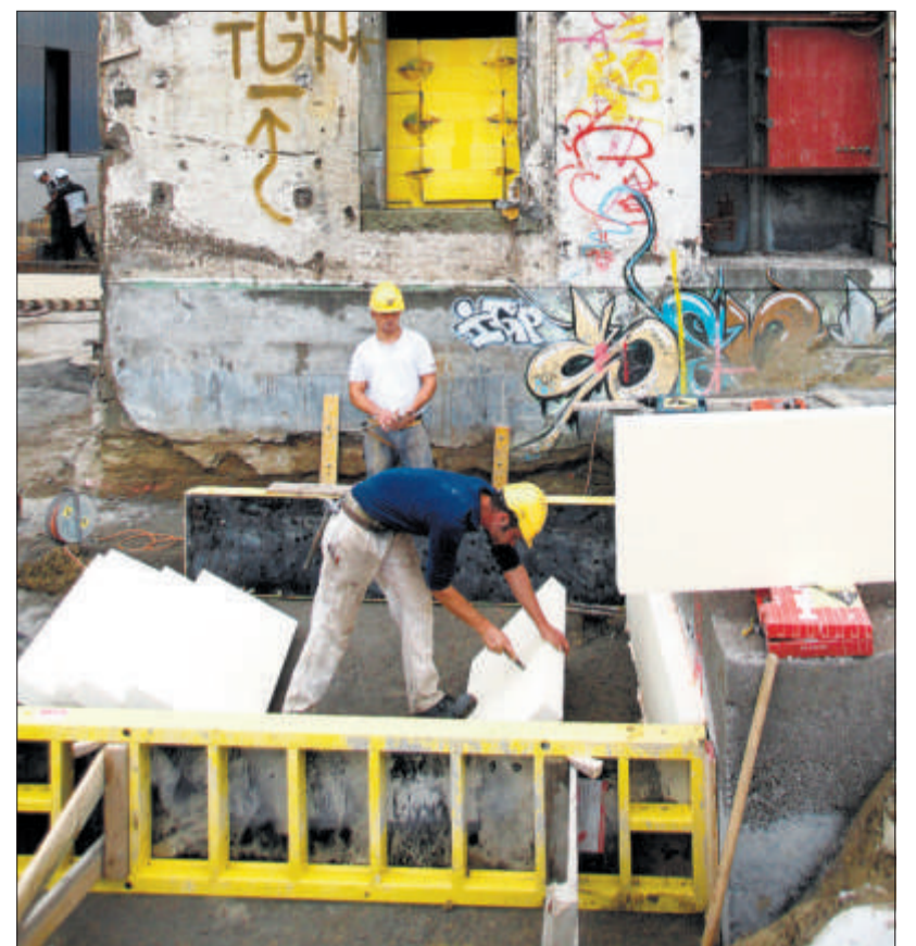
Die Isolation für den Boden des Neubaus macht den Anfang.
